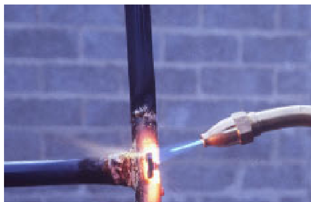
Figura 4.4 Construção – utilização de um maçarico silencioso © Yves Cousson – INRS França
